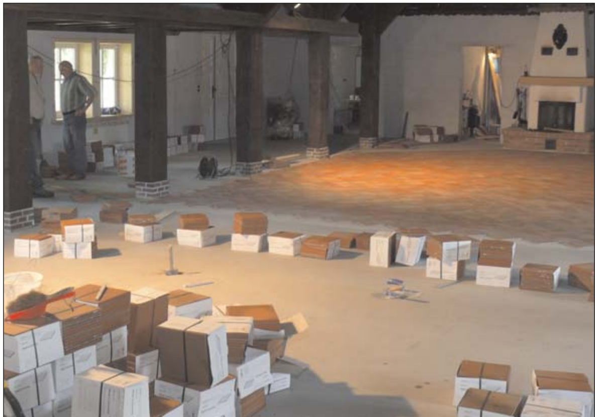
Der Fußboden des Dorphauses erstrahlt im warmen Rotbraun der inzwischen verlegten Fliesen.
