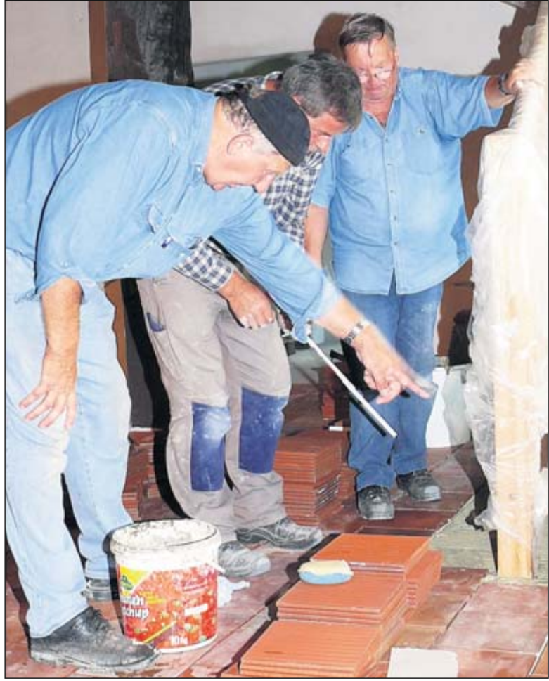
Claus Götjen (vorn) und Gerd Nowak (Mitte) berieten mit den ehrenamtlichen Helfern immer wieder Einzelheiten der Fliesenverlegung.
